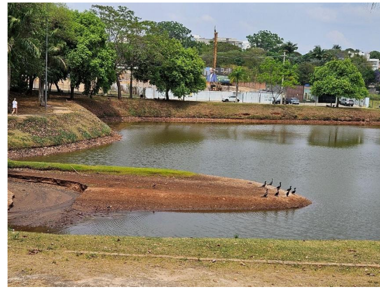
Talude erodido, assoreamento do lago do Parque dos Lagos
